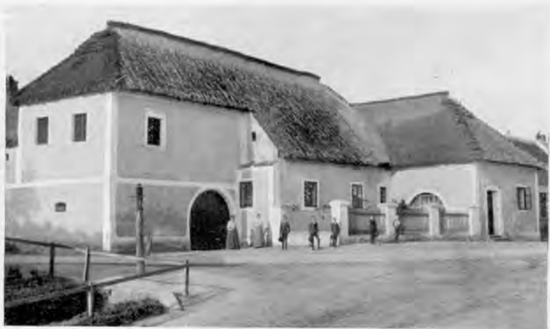
Haus Nr. 104 in der alten Bedachung
