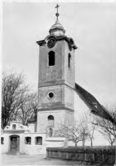
Turm der Pfarrkirche
