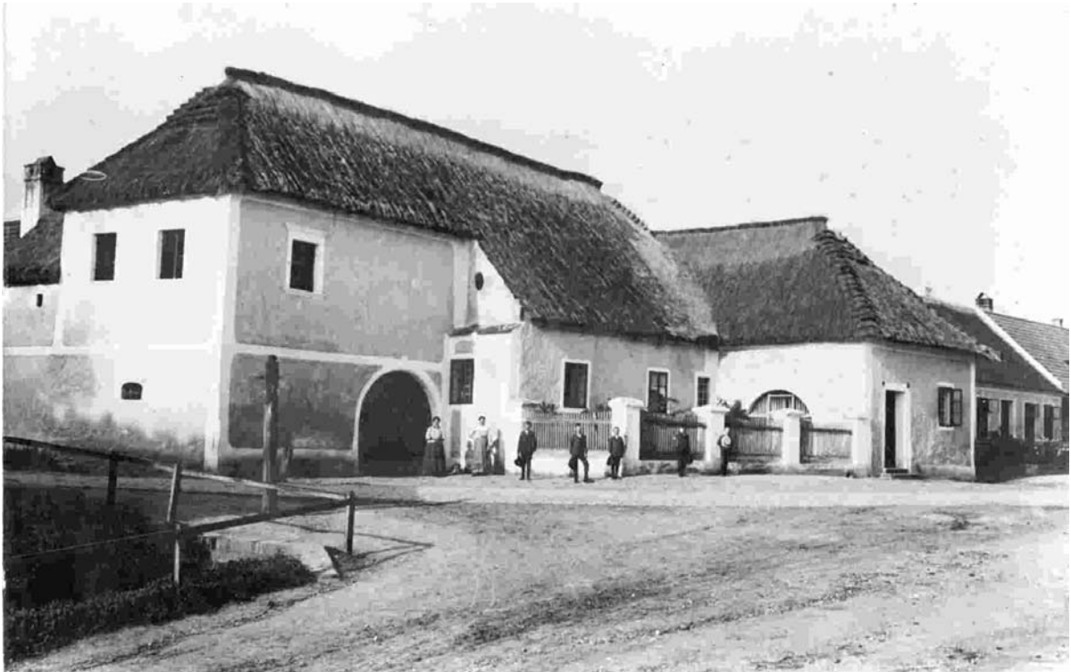
Haus Nr. 104 in der alten Bedachung
