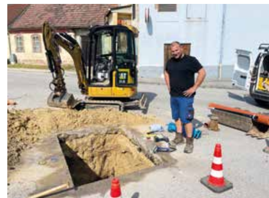
Gemeindearbeiter Stefan Löffler auf der Baustelle
