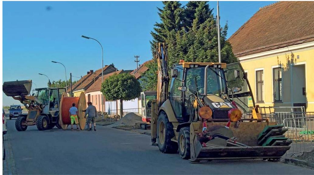
Bei diesen Arbeiten werden neue Gasleitungen verlegt, zusätzlich sind Leerverrohrungen für das Breitbandinternet vorgesehen. Die Saalbache und Hydranten werden freigelegt, seitens des Wassermeisters kontrolliert und bei Bedarf ausgewechselt.
