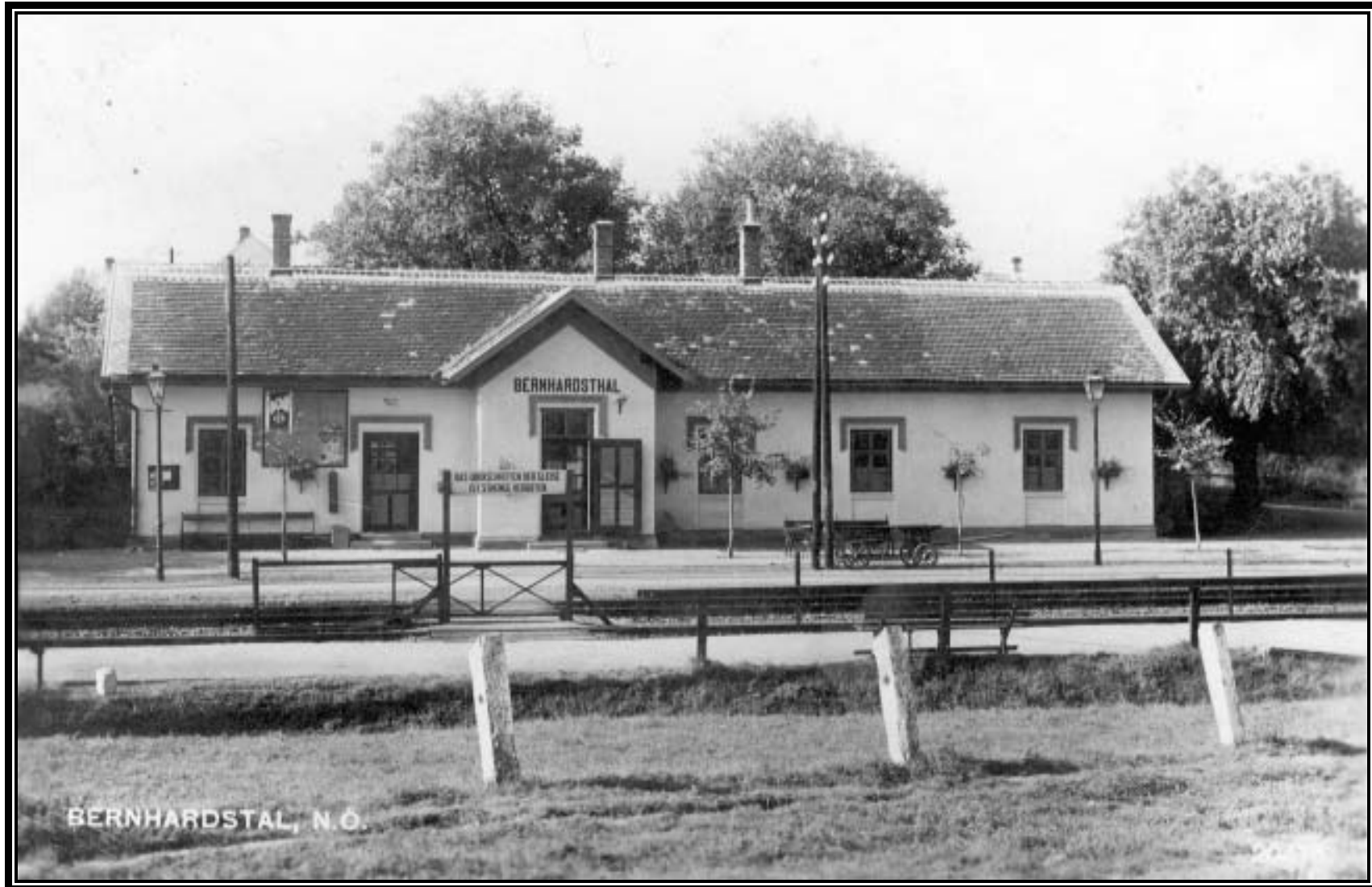
Die schon gepflanzten Linden deuten auf 1936 - 1938, der unsymmetrische Anbau, drittes Fenster Nord ist deutlich am Dach erkennbar. Er wurde um 1970 wieder entfernt.
