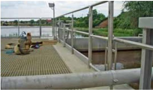
Die Bauarbeiten zur Erweiterung der Kläranlage wurden im August 2008 begonnen. Die bestehende Kläranlage wird von derzeit 1400 EW (Einwohnerwerte) auf 3100 EW erweitert. Dazu mussten zwei neue Stahlbetonbecken und ein Pflanzenfilter errichtet werden. Die bestehenden Becken werden derzeit saniert und umfunktioniert.
