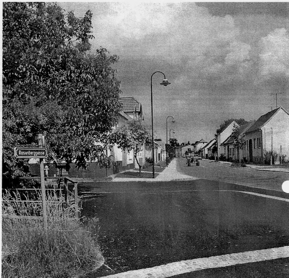
Die neue Straße trägt zur Verkehrsberuhigung bei.
