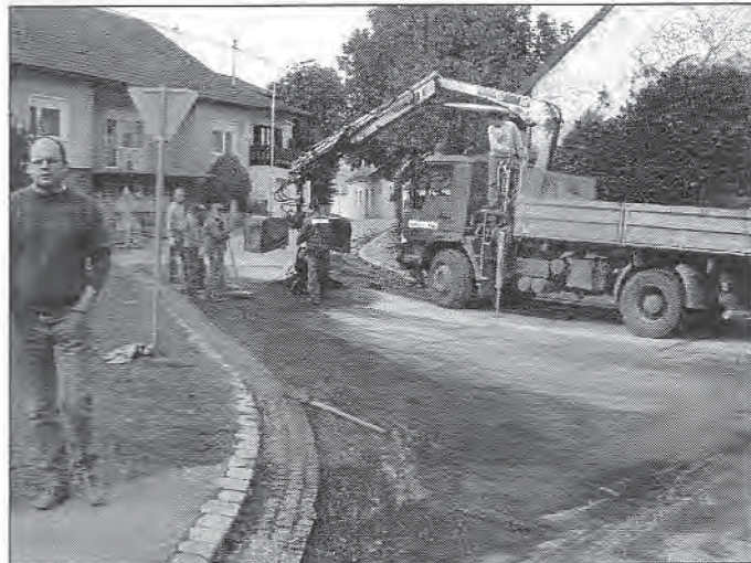
Straßenbauarbeiten in der Museumsgasse
